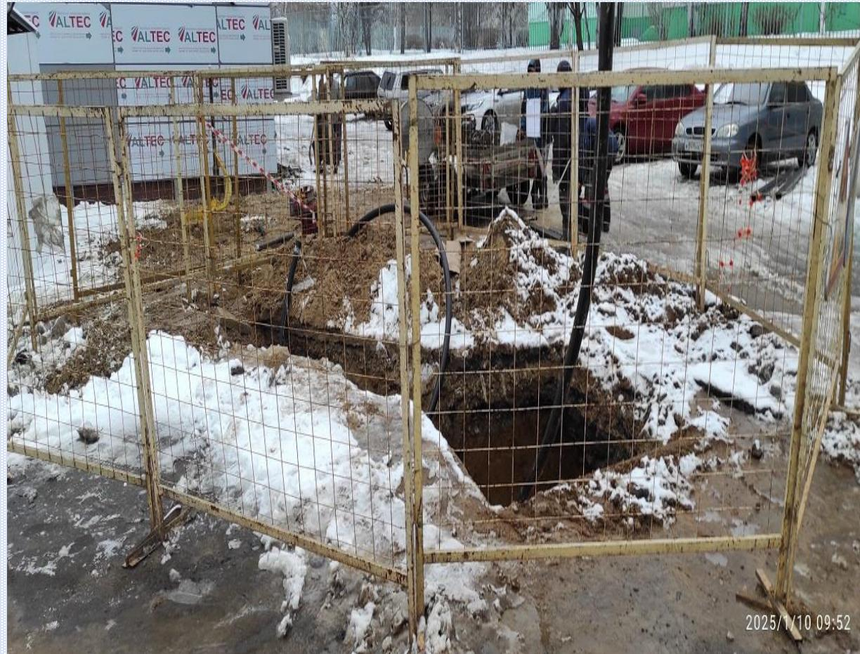
9.4. Место производства работ ограждается **щитами-заставками** установленного образца дорожными разделительными водоизливными блоками).
