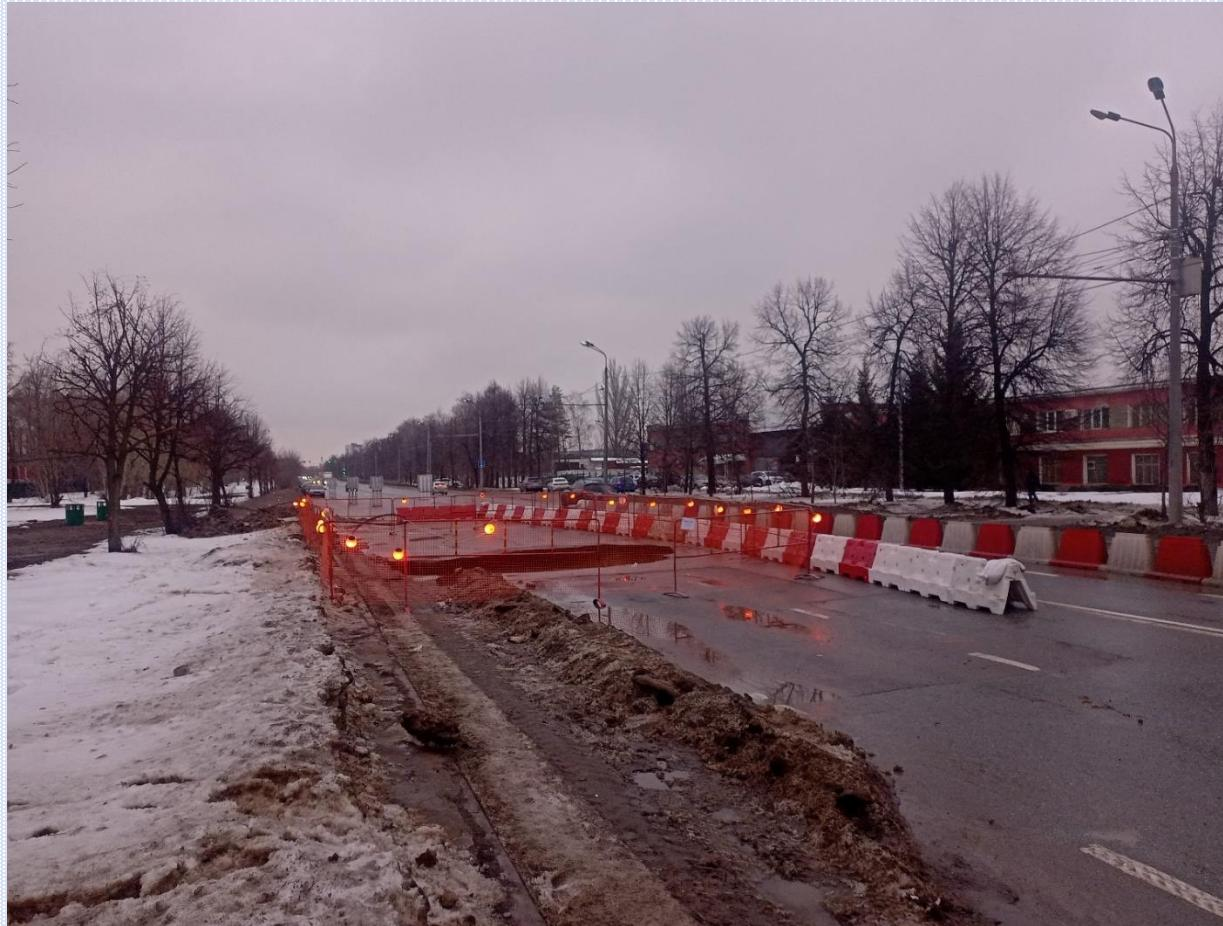
3.1.7. Организовать ограждение зоны производства работ, обеспечивающее безопасное движение транспорта и пешеходов, ...., ограждающие и направляющие устройства, пешеходные мостики с перилами шириной не менее 1,5 м, **красные фонари на углах ограждений** и не реже чем через каждые 50 м вдоль ограждения.
